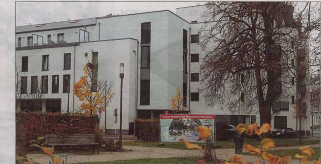
Im neuen Vereinshaus wurden Wohnungen auf drei Stockwerken eingerichtet.
