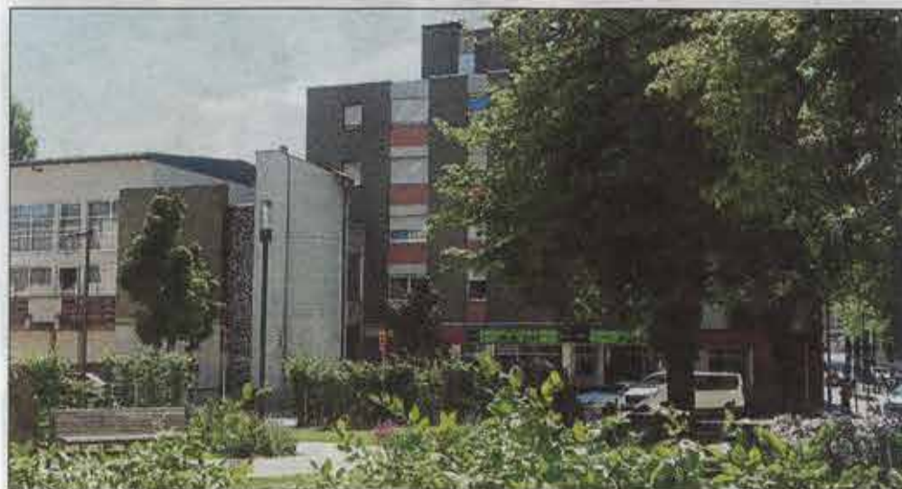
Das Vereinshaus könnte schon bald der Vergangenheit angehören. Der Anbau (r.) ist nicht vom Abriss betroffen. (FOTO: RAYMOND SCHMIT)
